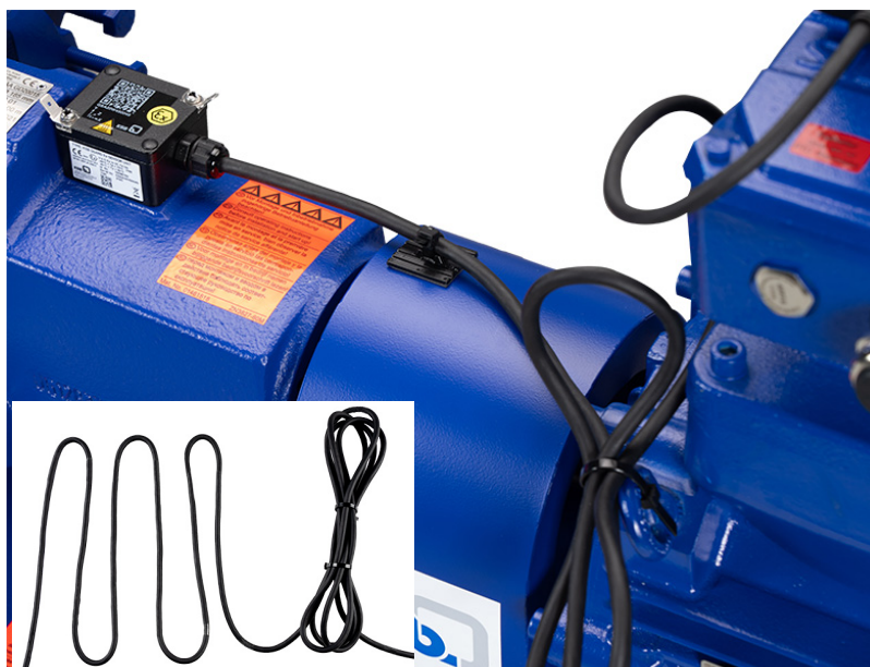
Fig. 14: Tendido del cable de conexión eléctrica de forma serpenteante
