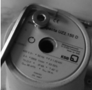
Fig. 14: Sentido de giro de la bomba
