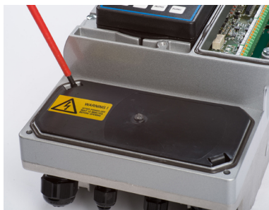
Fig. 13: Extracción de la cubierta de protección
